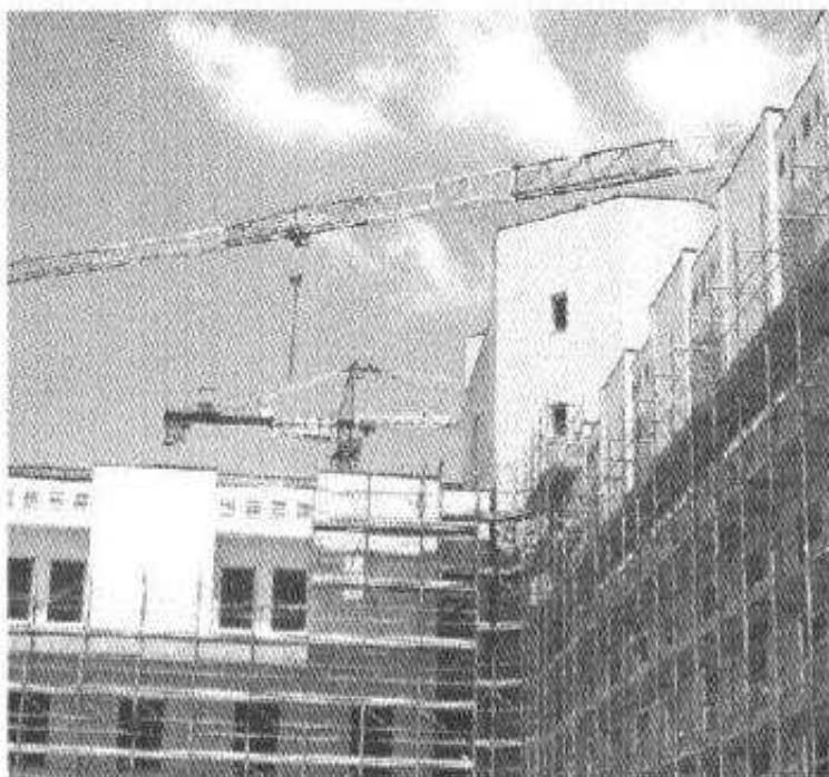
Foto di repertorio dei lavori al nuovo ospedale intitolato a Giovanni Paolo II
